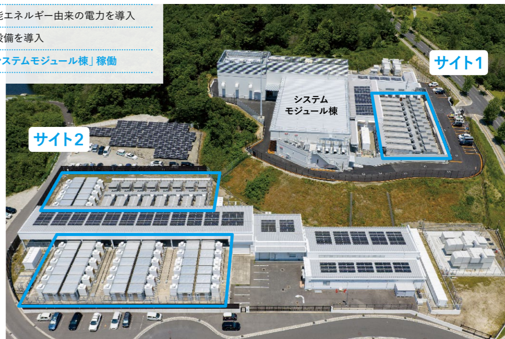
… コンテナ型DC設置エリア
