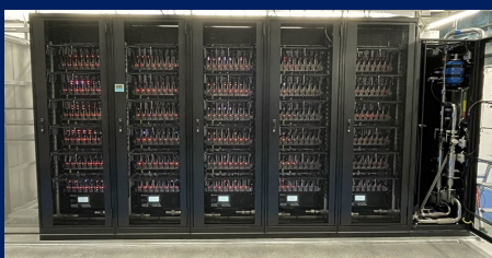
松江DCPIに設置された直接水冷のMN-Core 2サーバ30ノードおよび水冷設備
